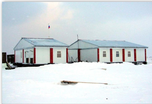
Реконструкция существующих полярных станций
