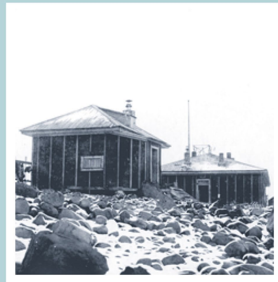
Станция на о.Диксон
